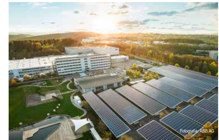
Fotografía izquierda: El nuevo compresor de tornillos de velocidad variable CSDX 175 SFC cumple el grado de rendimiento de sistema IES2. Fotografía derecha: La nueva planta fotovoltaica suministra aproximadamente 1,100 MWh de electricidad limpia al año.
