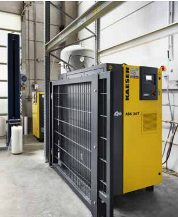
Fotografía inferior: El nuevo compresor de tornillo ASK 34 T SFC ofrece redundancia y prepara el tostadero para una demanda de aire comprimido creciente en el futuro.
