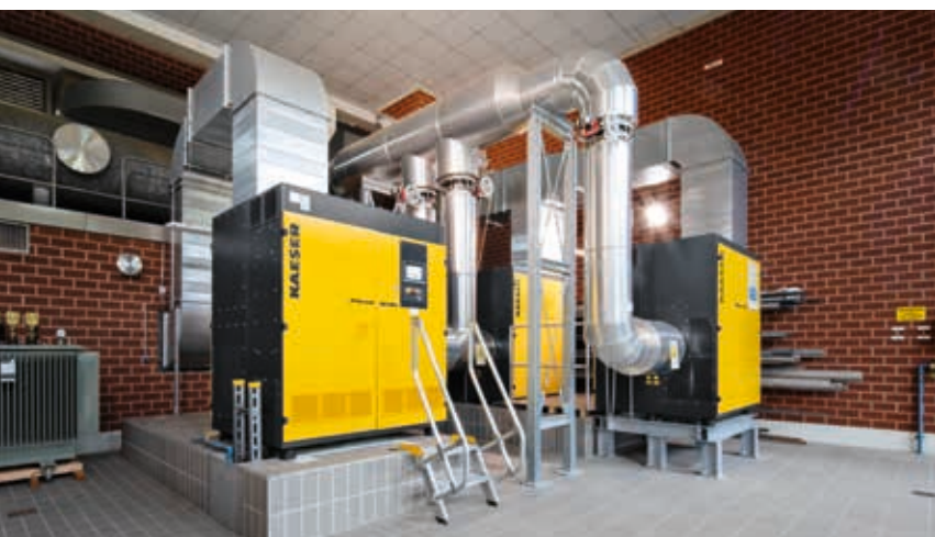
Los nuevos turbosopladores MP 6000 son la solución óptima para el rango de potencia exigido en este caso.
