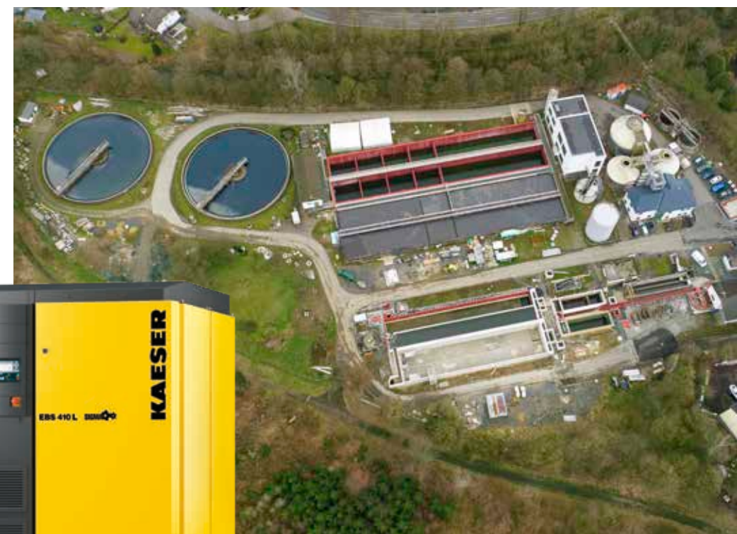
La planta depuradora de Herdorf vista desde el aire.
